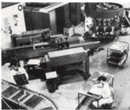
Commerciële productie van zonnecellen vraagt verregaand geautomatiseerde methoden. Deze foto geeft een beeld van een productieruimte van Telefunken Electronic. In het midden bevindt zich de lasautomaat waarmee voor- en achterzijden van zonnepanelen worden gelast, alsmede de computer die zorgdraagt voor de besturing van het geheel.
