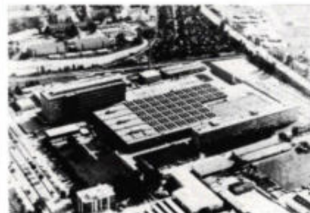
Siemens-complex in München-Freimann. Ruim 1600 medewerkers zijn hier uitsluitend belast met ontwikkeling en productie van vermogens-halfgeleiders, waaronder SiPMOS- (Siemens Power MOS) transistoren.
